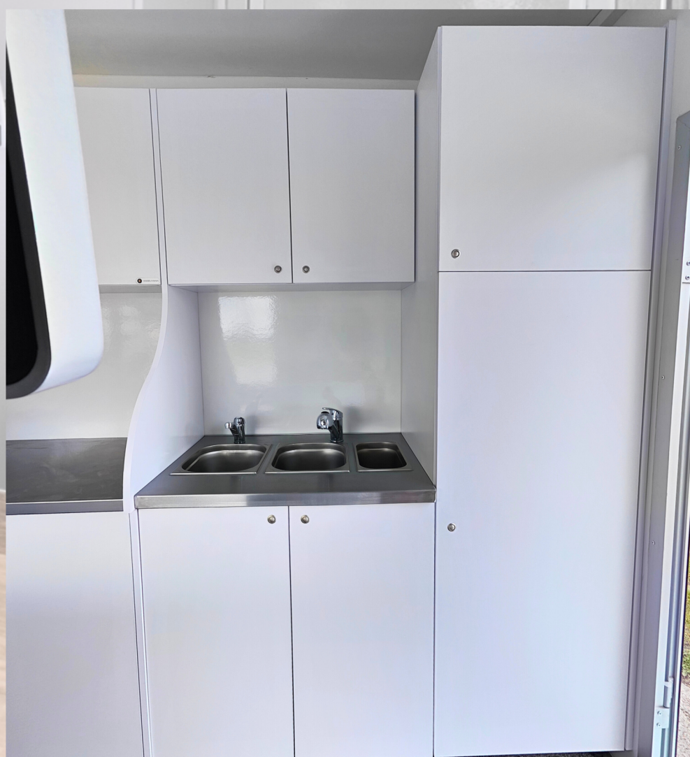
Zaplecze sanitarne z szafką BHP
